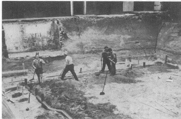
Schützensaalneubau 1974 - die Entwässerungsleitungen werden in Eigenarbeit ausgeführt v.l.n.r.: Toni Kollenbroich, Hans Baumer, Peter Breuer, Friedel Schotten
